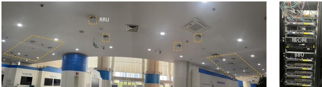
图 5-14 商用终端接入无蜂窝网络测试环境
